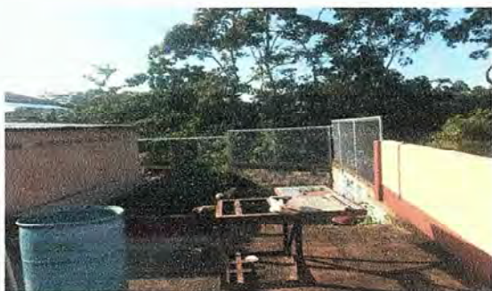
Foto 1: Reparación de tubo hg y malla galvanizada.
