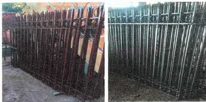
Foto 2: Sustitución de barandas de metal.
