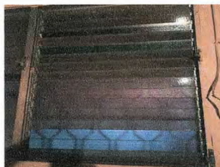
Foto 4: Sustitución de vidrios.
