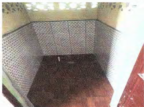
Foto 3: Sustitución de inodoro, piso cerámico y azulejo.
